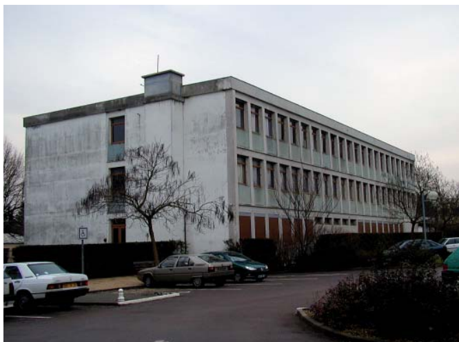
L'« ancien collège » de la rue Anatole-France, devenu École Anatole-France en 2000, après rénovation complète du bâtiment.
